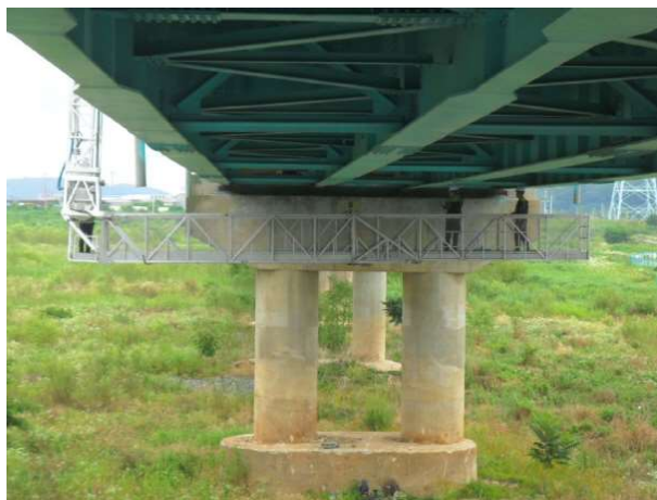
교량굴절차를 이용한 외관조사(예)
