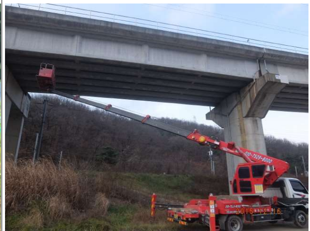
고소점검차를 이용한 외관조사(예)
